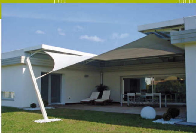
Copertura a vela
